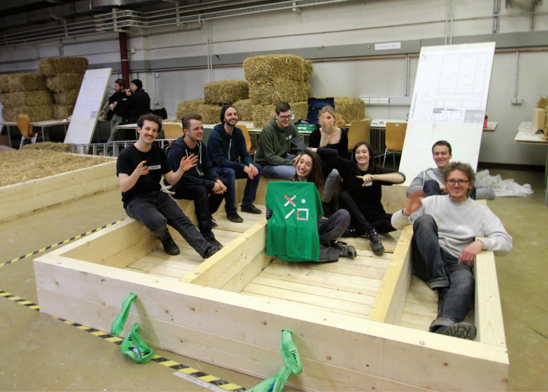
Als erstes haben die Studierenden das Holz für den Holzrahmen zugesägt und zusammengeschrubt. In den oberen Riegel wurde die Verladeschleufe eingefügt.
