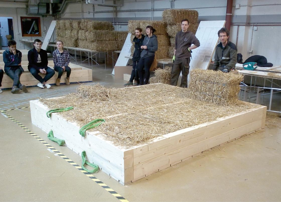
**Der Holzrahmen wurde gewendet und die Strohballen wurden liegend eingefügt. Löcher wurden gestopft und die Oberfläche mit der Heckenschere gemäht.**
