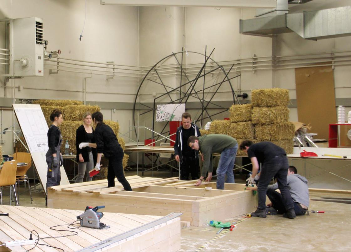
**Danach wurde die diagonale Rauh-schalung montiert. Diese dient der Aus-steifung.**
