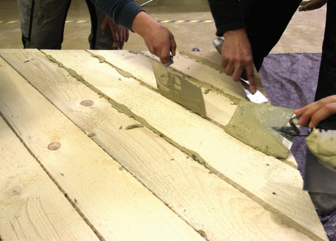
**Danach wurde die Fassade gewendet und die Fugen der Rauhschalung mit Lehm abgedichtet.**
