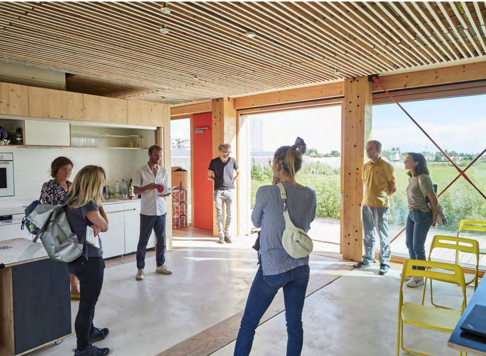
Multifunktionsraum im EG des Prototyps: Kochzeile mit Nasszelle, Eingangstür, barrierefreie Doppelschiebetür, Estrich, abgehängte Decke mit Bauteilheizung
