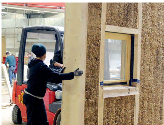
Strohballendämmung in der Außenwand
