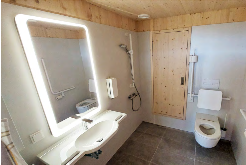
Barrierefreie Nasszelle im EG, Tür zum Technikraum
