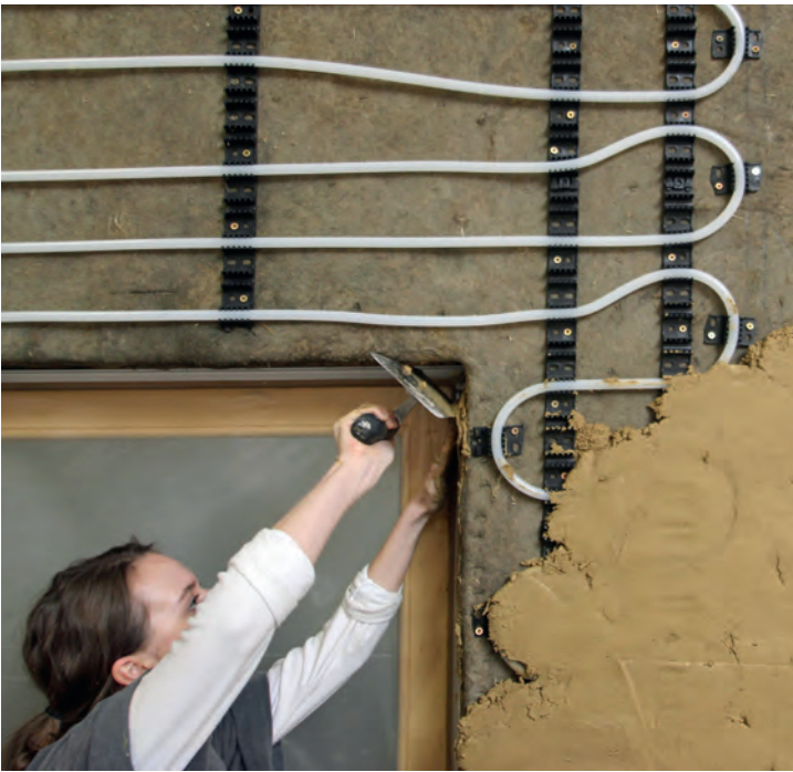
Aufbringen von Lehmputz auf eine Wand mit Bauteilheizung
