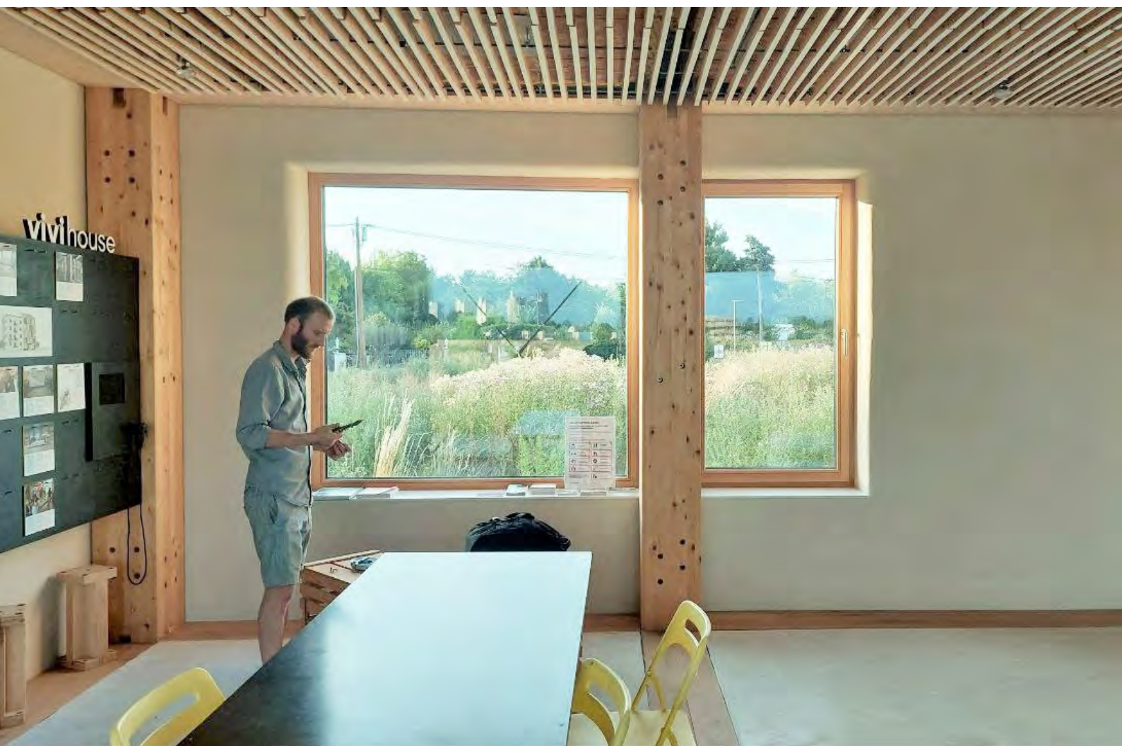
Multifunktionsraum im EG des Prototyps im Wiener Donauebene: Holzstützen, Holzfenster mit Dreifachverglasung, Lehm-Edelputz, Estrich, abgehängte Decke mit Bauteilheizung
