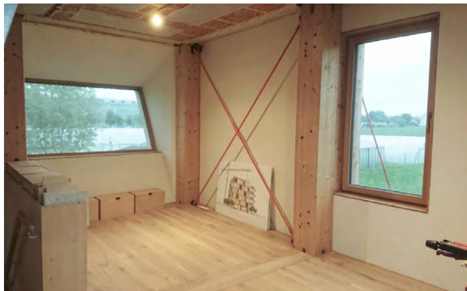
Raum im OG mit Erker und Diagonalaussteifung
