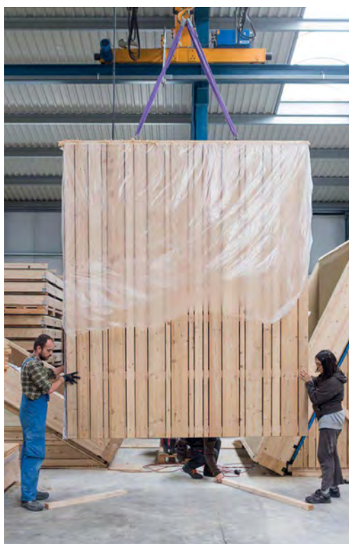
Außenwand mit hinterlüfteter Holzfassade in der Vorproduktion
