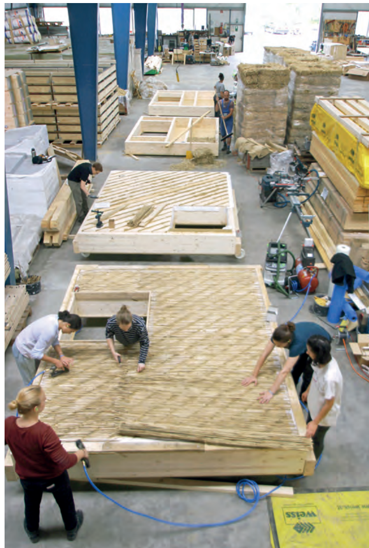
Produktionsstraße nach der Lean Production
