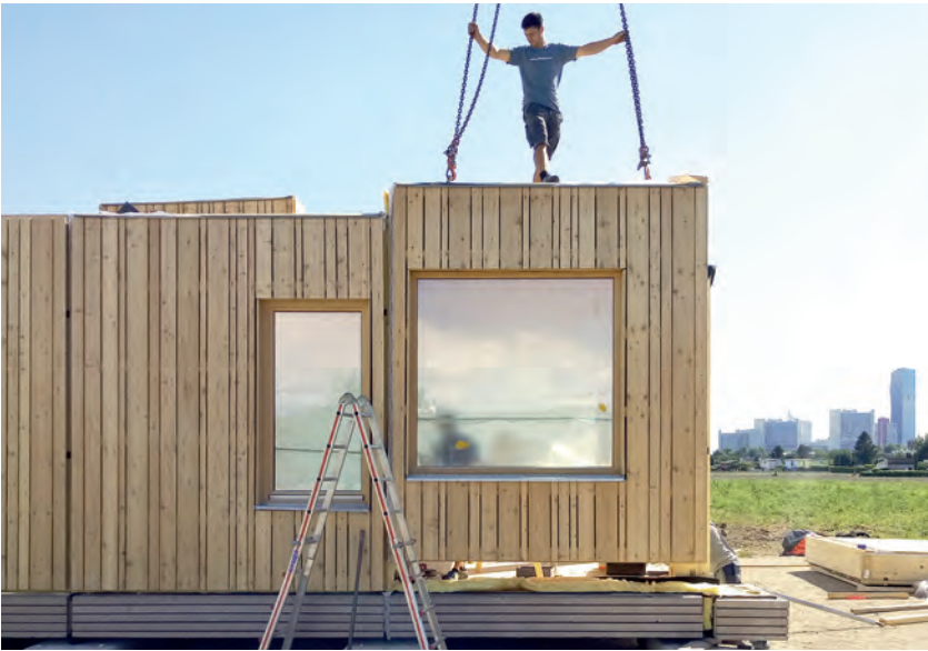
Verheben und Montieren eines Fassadenelements vor Ort im Wiener Donauefeld
