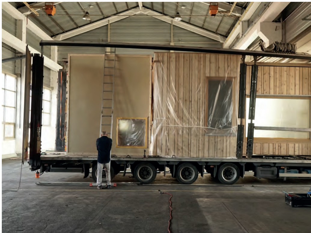
Logistik und Transport von Elementen per LKW
