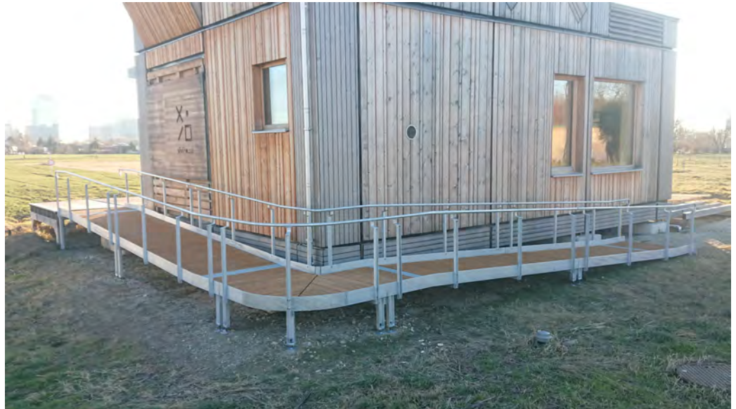
Modulare vivihouse-Rampe zur barrierefreien Erschließung aus feuerverzinktem Stahl, Holzdielen, LED-Beleuchtung
