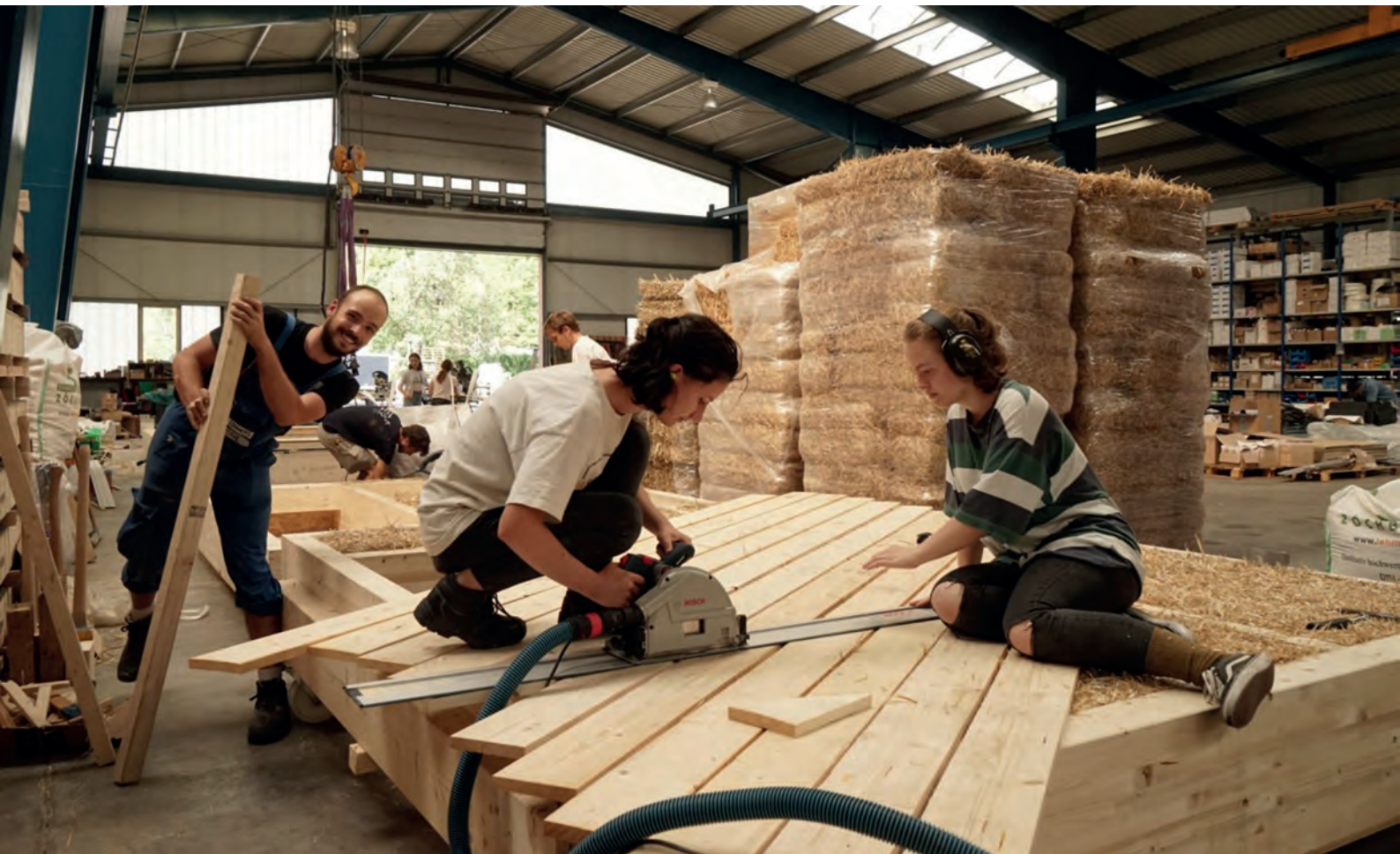
Vorproduktion mit Studierenden unter Anleitung: Diagonalverschalung auf Wandelement
